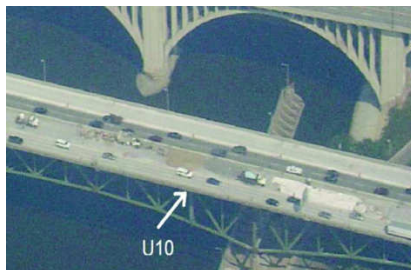
图2 (a) 事故发生前两小时 I-35W 大桥路况 (NTSB)
