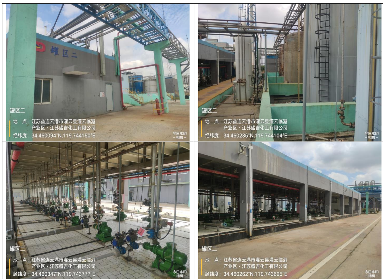
图 5.3-11 “罐区二”现场踏勘照片
