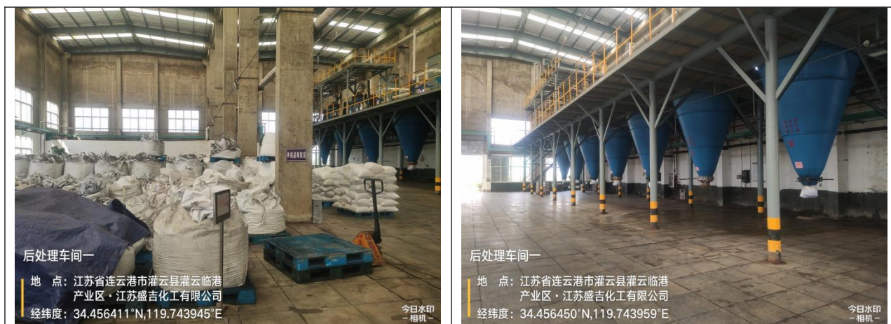
图 5.3-3 “后处理车间一”现场踏勘照片
