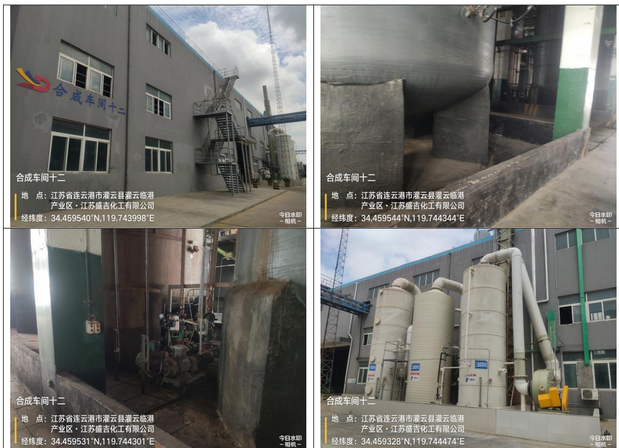
图 5.3-2 “合成车间十二”现场踏勘照片
