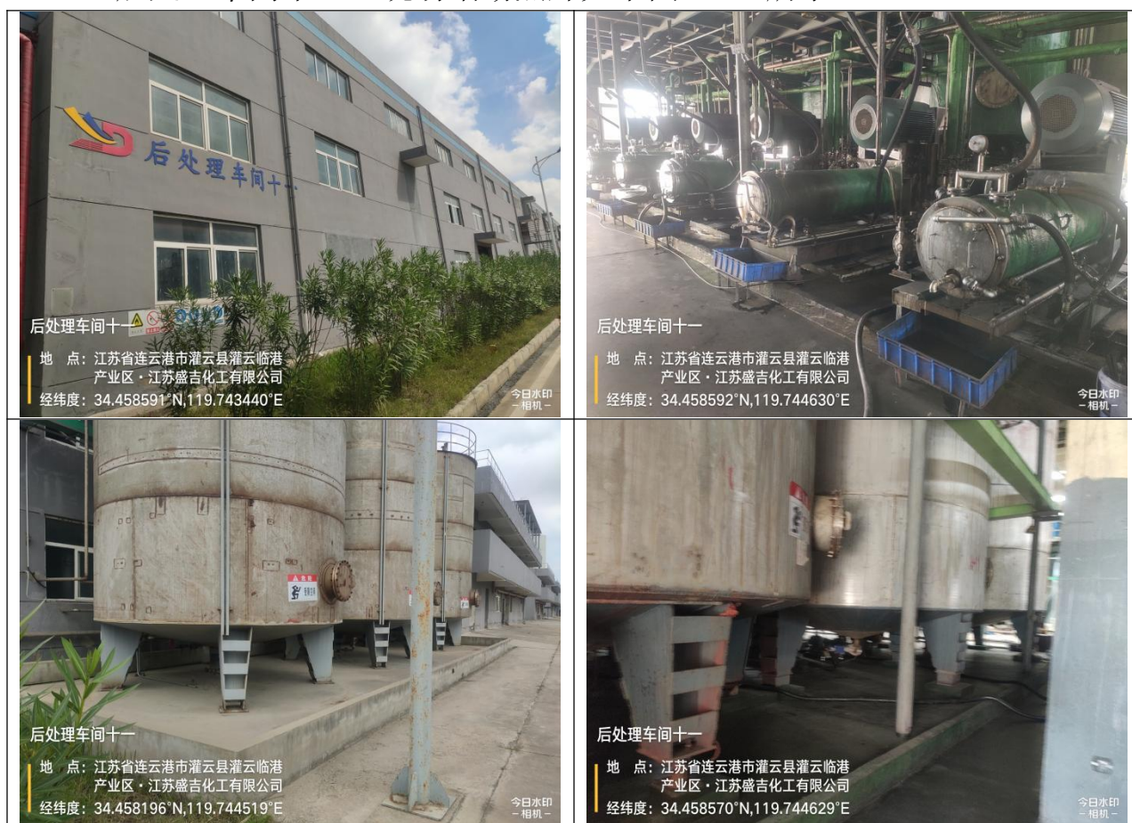
图 5.3-6 “后处理车间十一”现场踏勘照片
