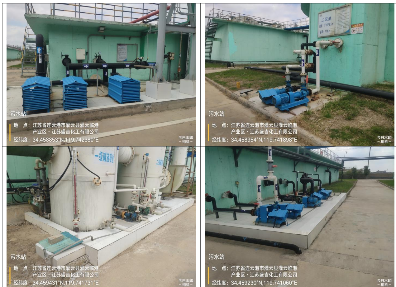
图 5.3-13 “污水处理站”现场踏勘照片
