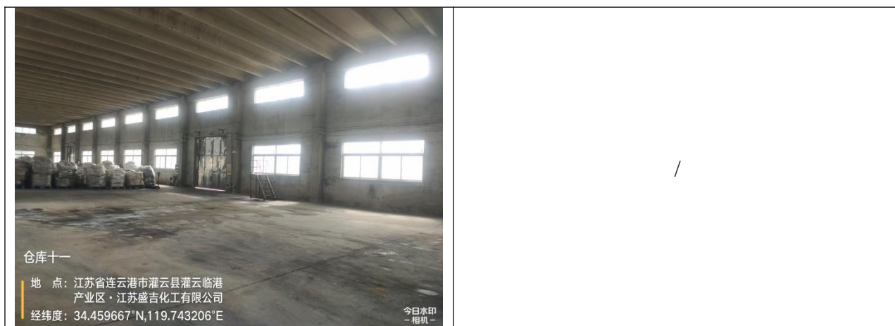
图 5.3-9 “仓库十、十一”现场踏勘照片
