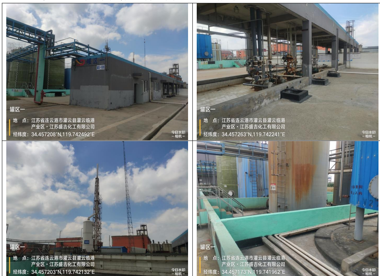
图 5.3-10 “罐区一”现场踏勘照片
