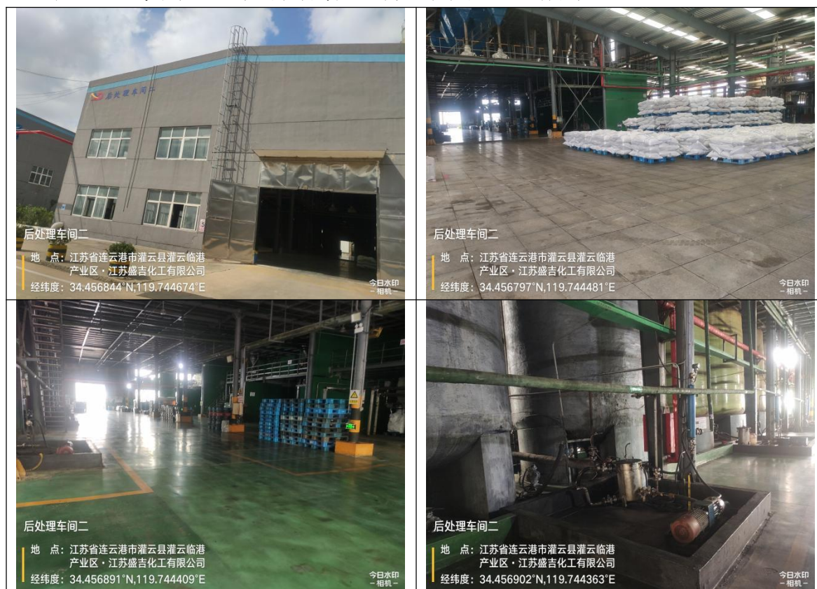
图 5.3-4 “后处理车间二”现场踏勘照片
