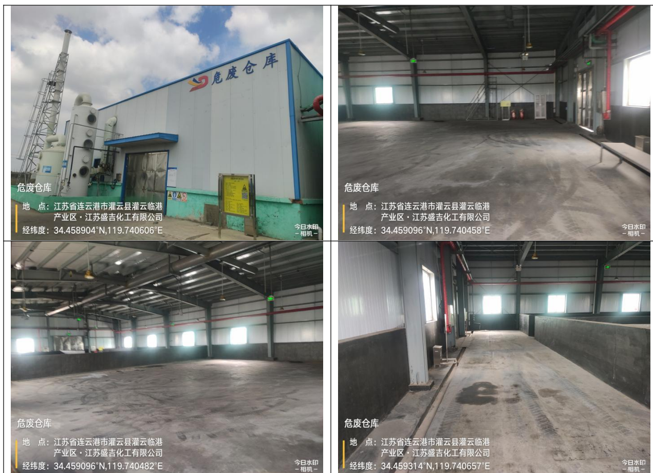
图 5.3-12 “危废仓库”现场踏勘照片
