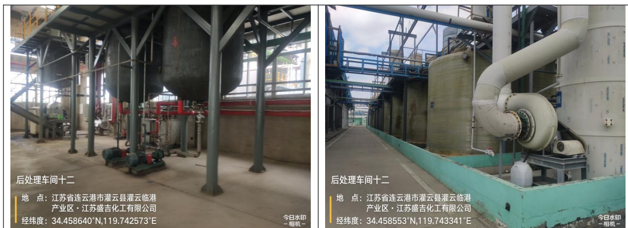
图 5.3-7 “后处理车间十二”现场踏勘照片
