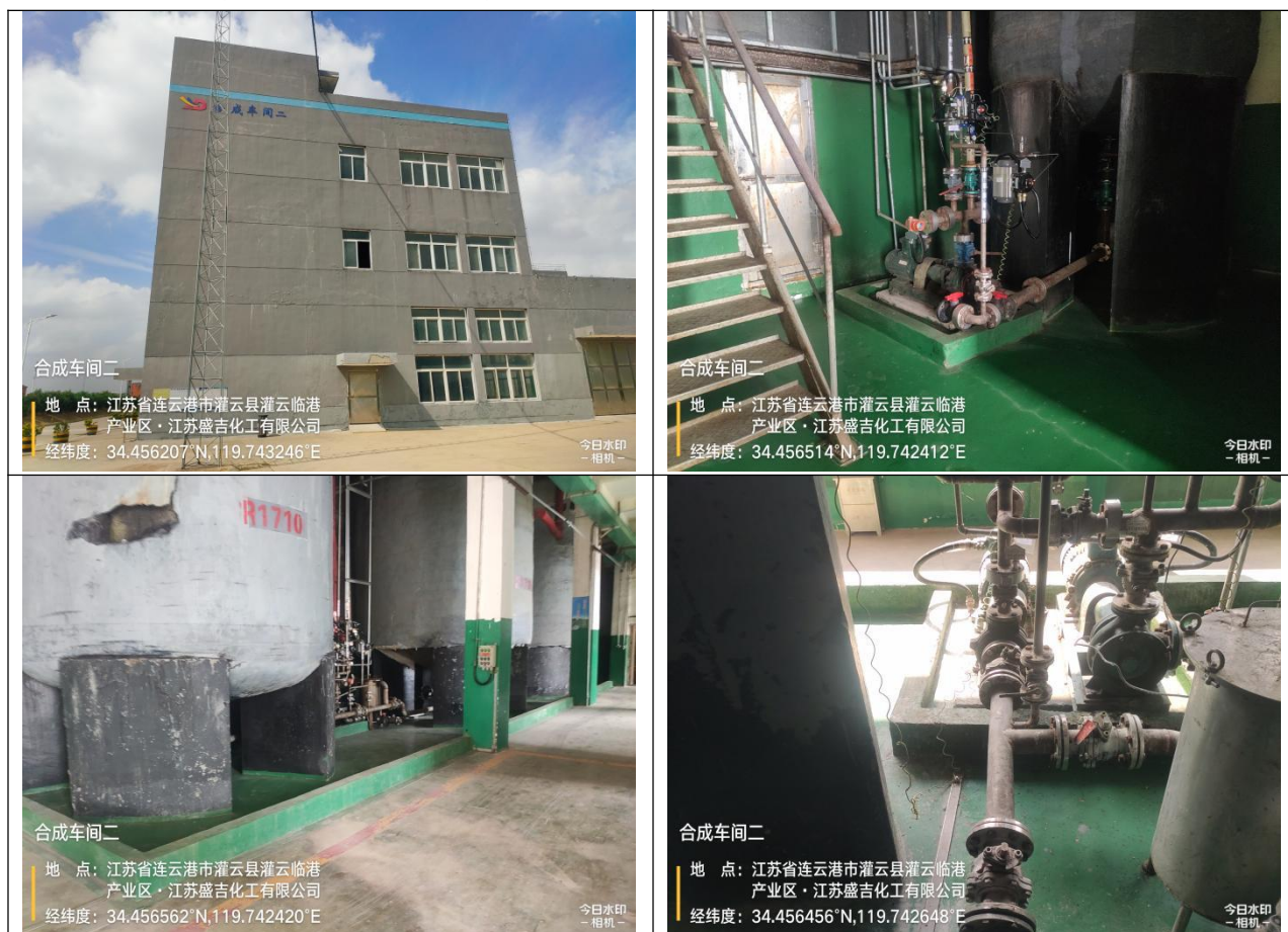
图 5.3-1 “合成车间二”现场踏勘照片
