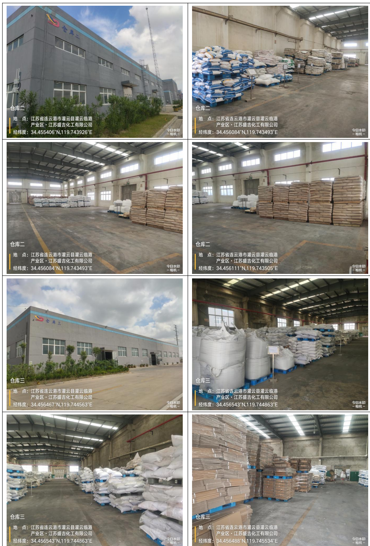
图 4.2-8 “仓库一、二、三”现场踏勘照片
