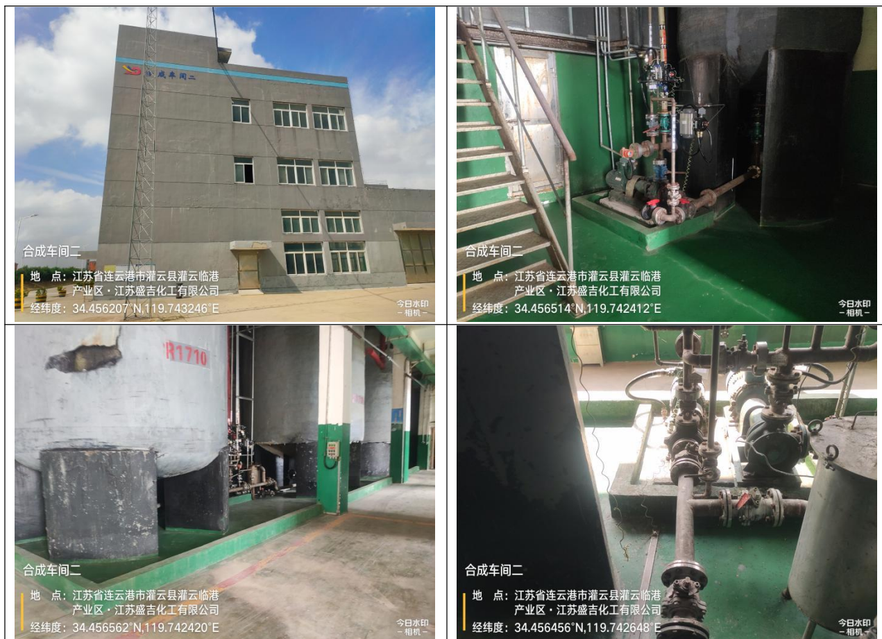
图 4.2-2 “合成车间二”现场踏勘照片
