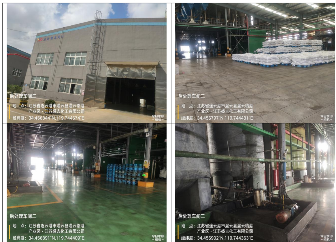
图 4.2-4 “后处理车间二”现场踏勘照片
