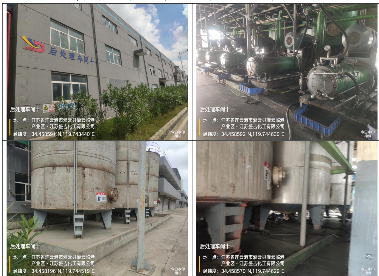
图 4.2-6 “后处理车间十一”现场踏勘照片
