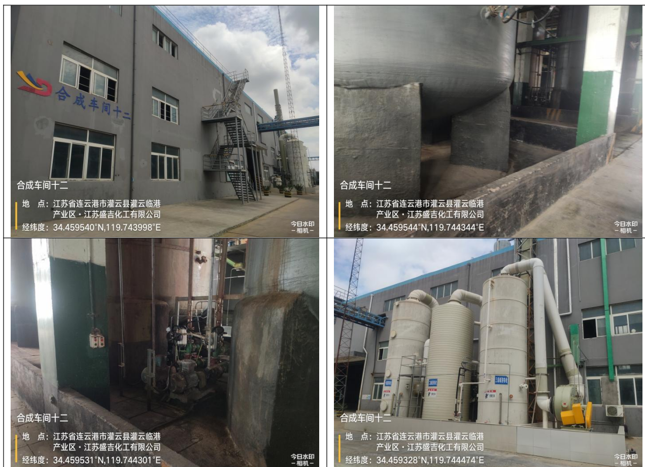
图 4.2-2 “合成车间十二” 现场踏勘照片
