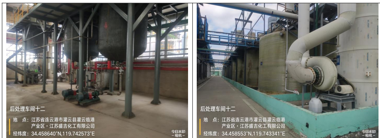
图 4.2-7 “后处理车间十二”现场踏勘照片
