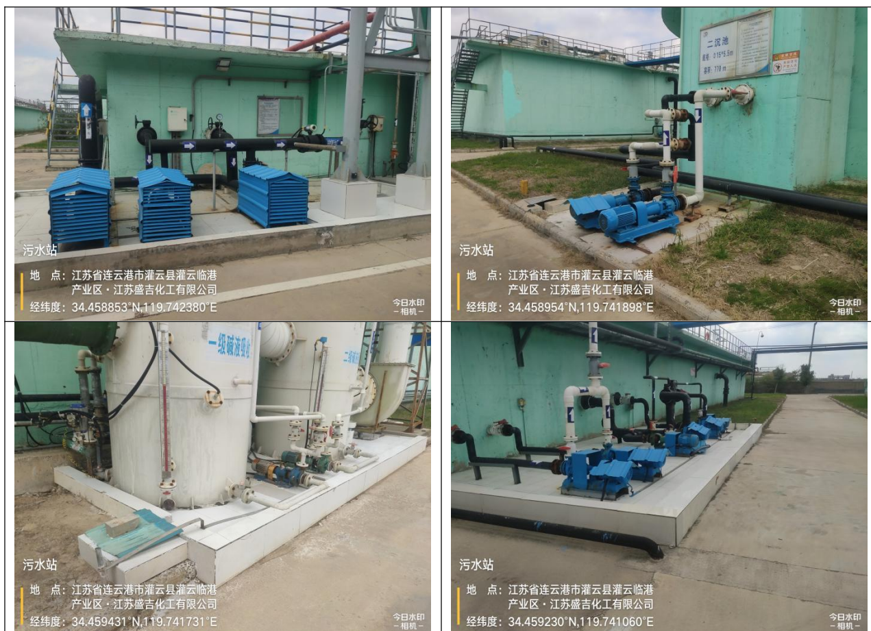
图 4.2-13 “污水处理站”现场踏勘照片
