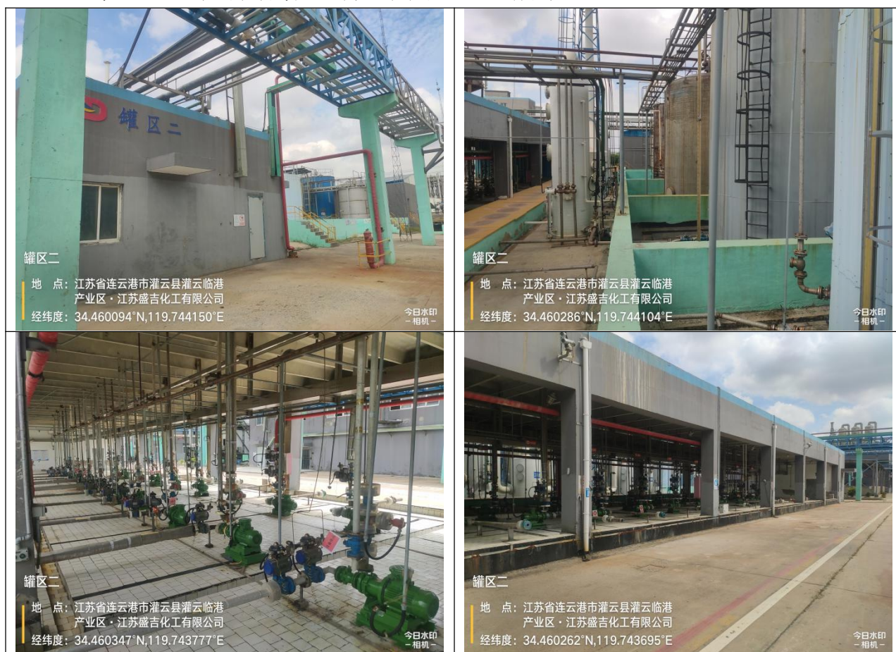
图 4.2-11 “罐区二”现场踏勘照片
