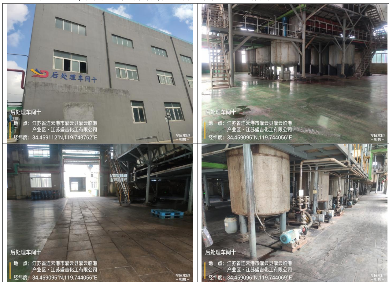
图 4.2-5 “后处理车间十”现场踏勘照片
