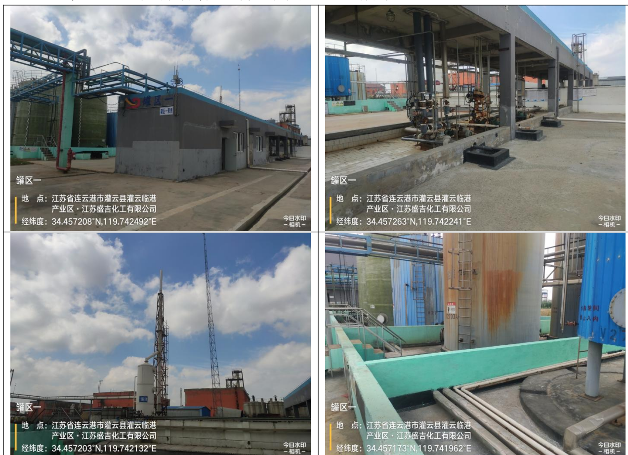
图 4.2-10 “罐区一”现场踏勘照片
