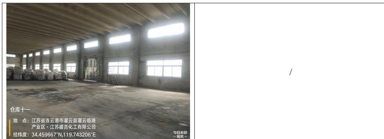
图 4.2-9 “仓库十、十一”现场踏勘照片
