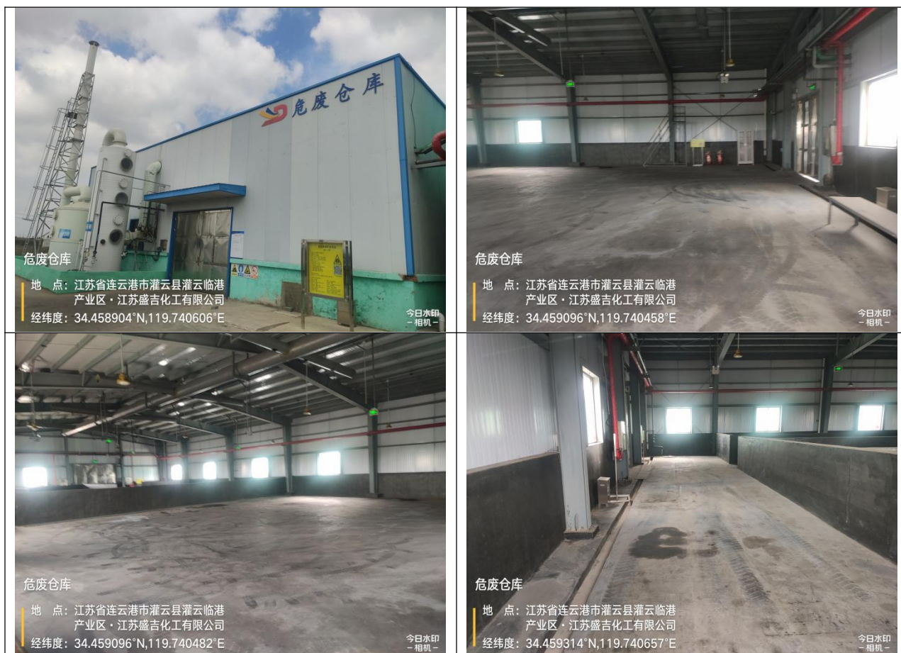
图 4.2-12 “危废仓库”现场踏勘照片
