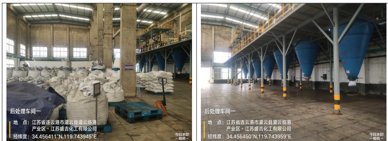
图 4.2-3 “后处理车间一”现场踏勘照片
