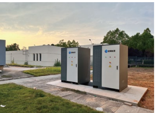
规模: 1000kW/2150kWh 项目: 东莞市·某医疗企业储能项目
