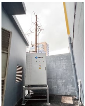
规模: 100kW/215kWh 项目: 广州市·某物业公司储能项目
