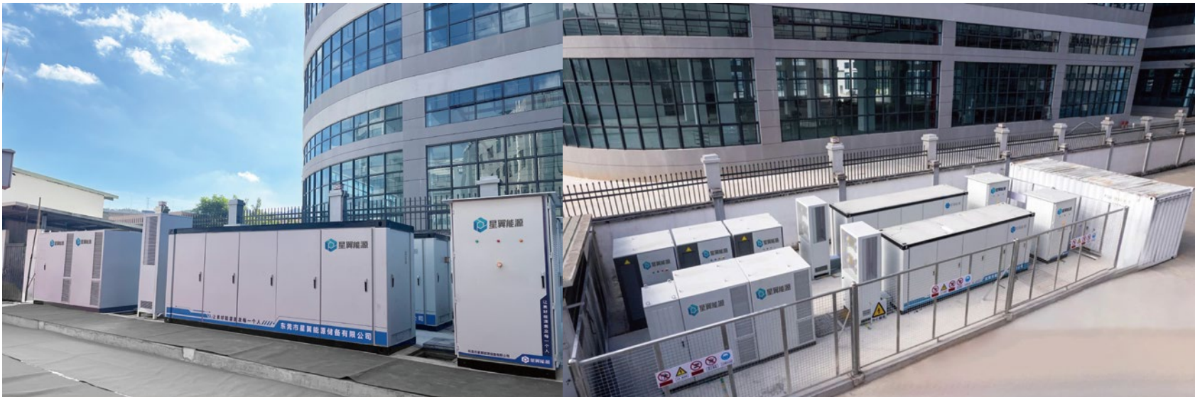
规模: 1500kW/3225kWh 项目: 东莞市·某电气维护有限公司储能项目
