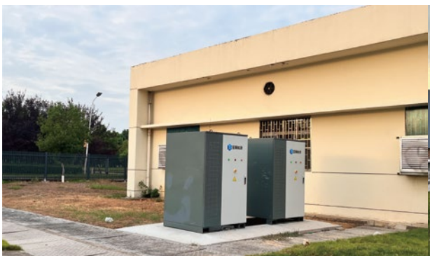
规模: 200kW/430kWh 项目: 咸宁市·某食品工业园储能项目
