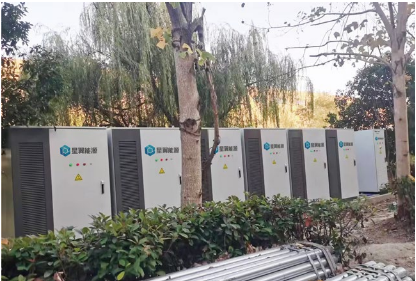
规模: 600kW/1290kWh 项目: 海宁市·某橡塑厂储能项目
