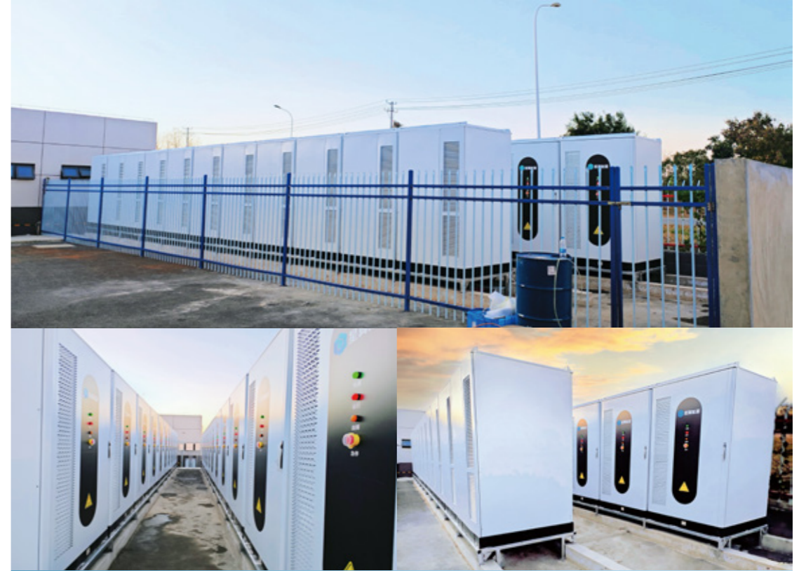
规模：2.3MW/4.945MWh 项目：江苏省扬州市·某材料科技有限公司储能项目
