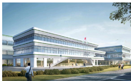
建设中的“广东微纯生物新材料有限公司”生产基地
