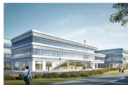
建设中的“广东微纯生物高新材料有限公司”生产基地
