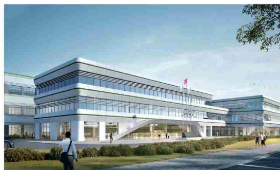
建设中的“广东微纯生物高新材料有限公司” 生产基地
