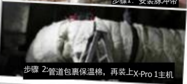
步骤1: 安装脉冲带
