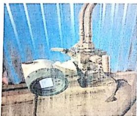
锅炉主蒸汽多变量流量变送器 (DP, P, T, Flow)
