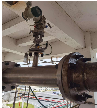
DN150单孔只插100, 测量氢气(视频差压为37.5Pa)
