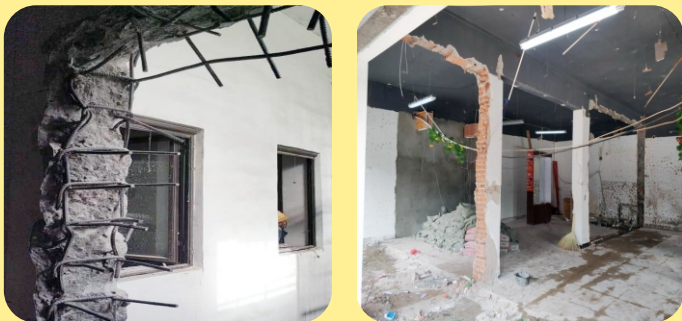
拆除建筑中具有房屋抗震的主体结构
