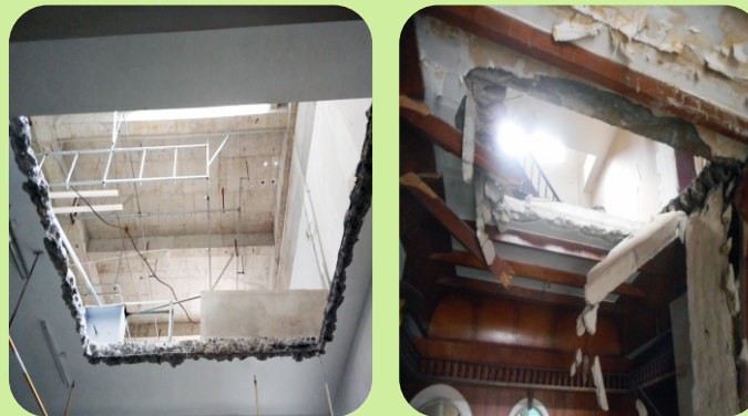
在楼面、屋面结构层开凿或者扩大洞口
