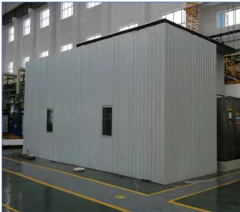
安装CAS隔声墙体后的隔声房外**约70分贝**
