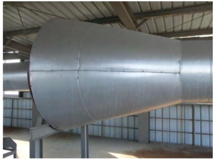
异径接头保温施工
