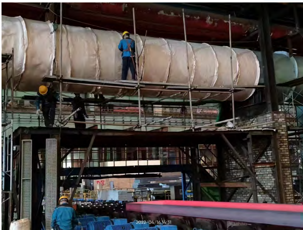
CAS保温施工
