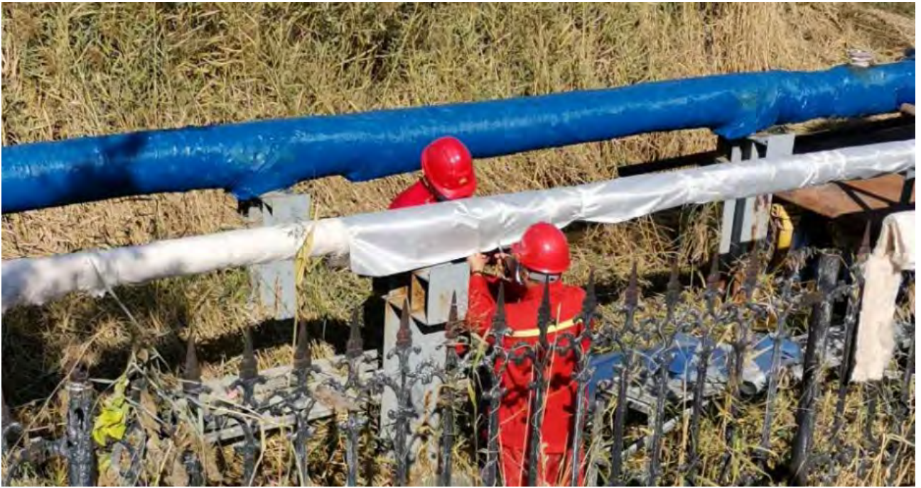
反射膜施工
