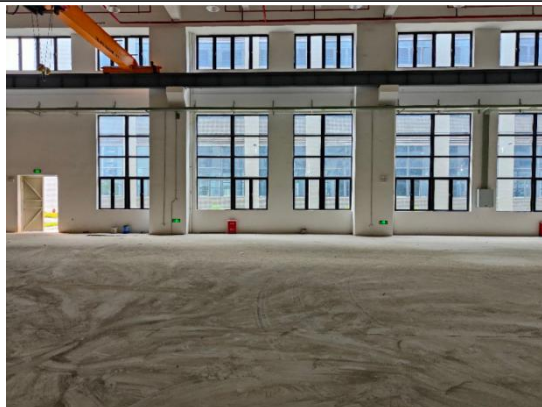
设备拟安装使用区域 2
