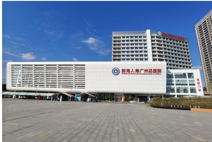
南面室外场所（50 米内）
