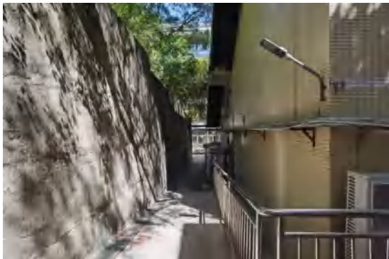
机房西面是室外过道（西侧为院内混凝土墙）
