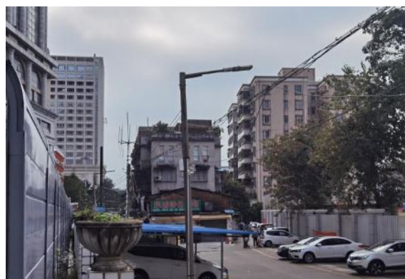
西北面 1-5 号居民楼（约 34~50 米）
