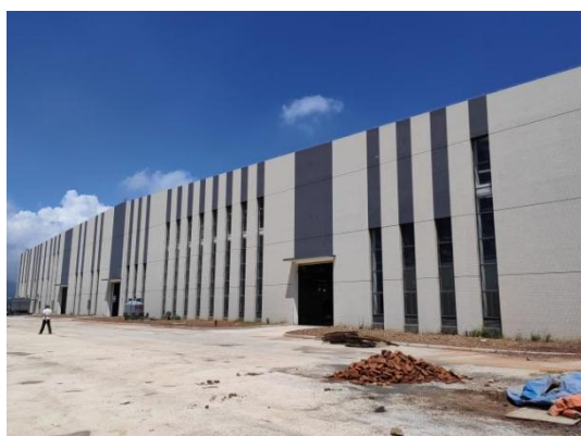
项目拟建位置东北侧电力电缆车间外部现状
