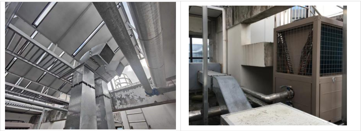
图 3-1 顶楼排风口现状图
