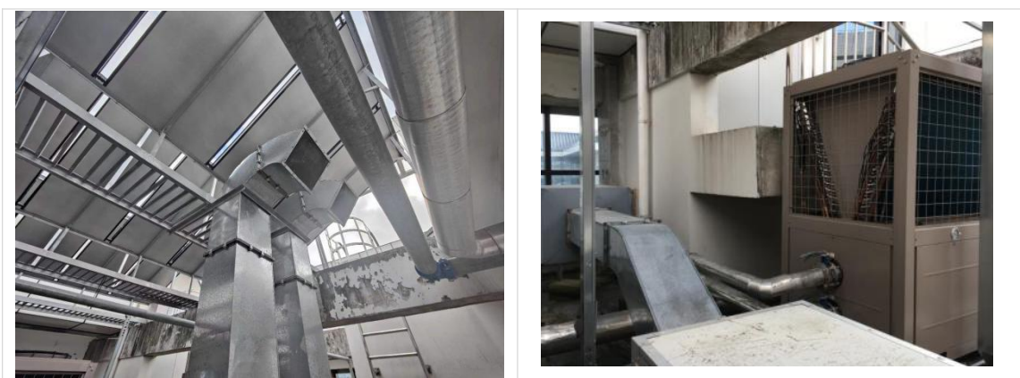
图 3-8 顶楼排风口现状图
