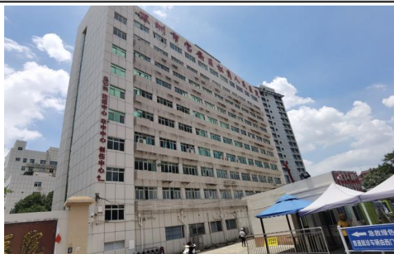
DSA 项目所在大楼
