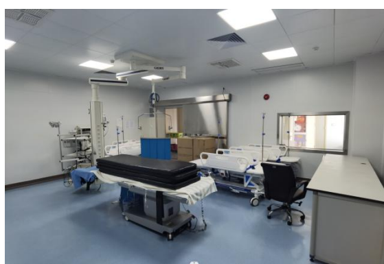
现状 ERCP 机房
