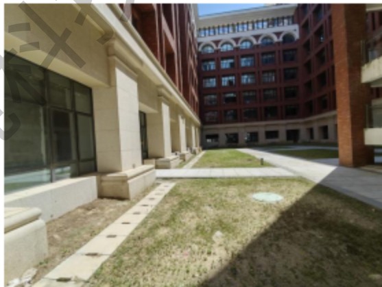
岩芯 CT 扫描仪南侧户外空地现状
