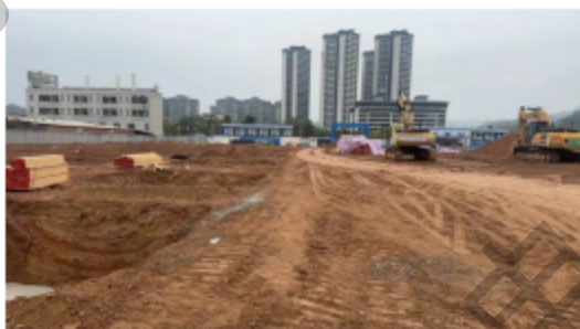
拟建位置东北侧现状
