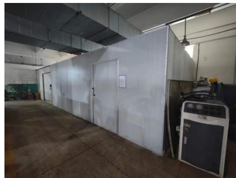
拟建探伤室对应楼上仓库
