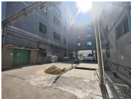
拟建探伤室东南侧厂区道路
