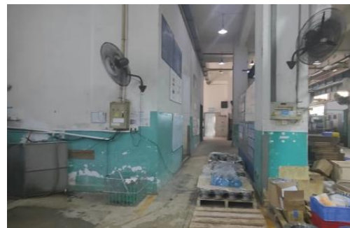
拟建探伤室西南侧环境现状
