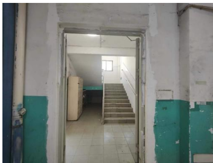
拟建探伤室东北侧楼梯间
