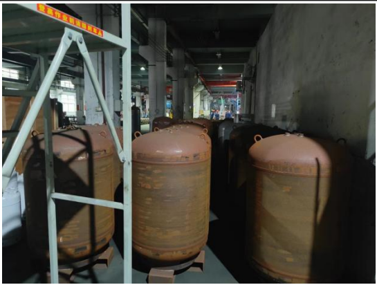
拟新建操作室现状
