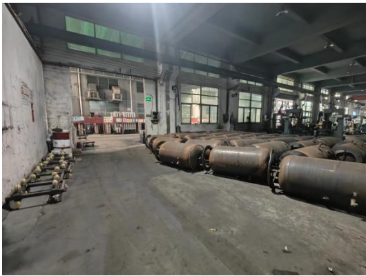
拟扩建探伤室场址现状（北侧视角）
