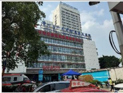
建设单位入口（急诊楼）
