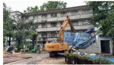
总务科楼（拆迁中）办公楼
