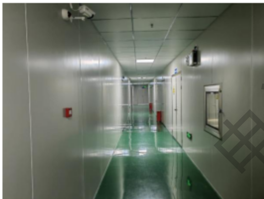
项目位置现状
