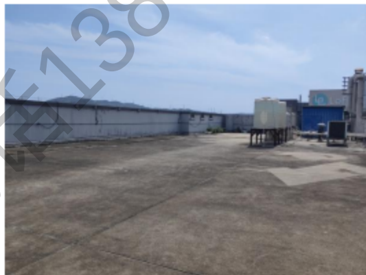
项目位置楼上天面现状
