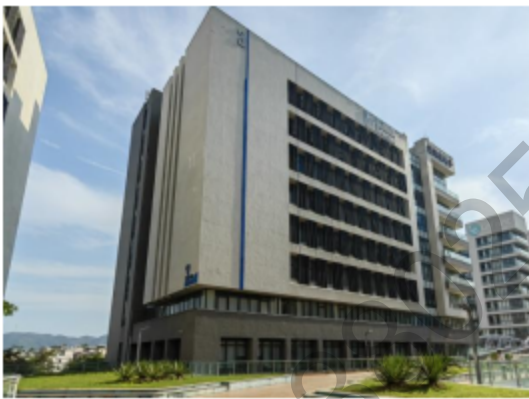
项目位置北侧7号楼现状
