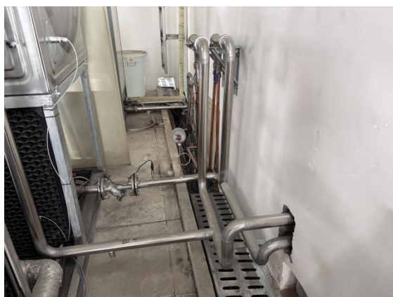
图 3-7 辐照室排放管道设计图
