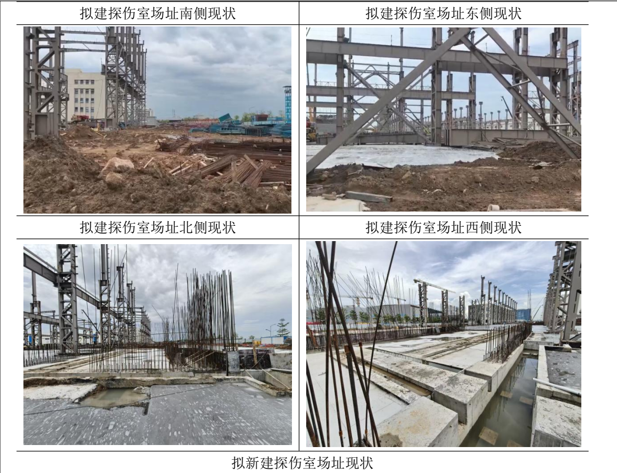
图 8-2 项目拟建区域及周边环境现状（目前现场现状）
