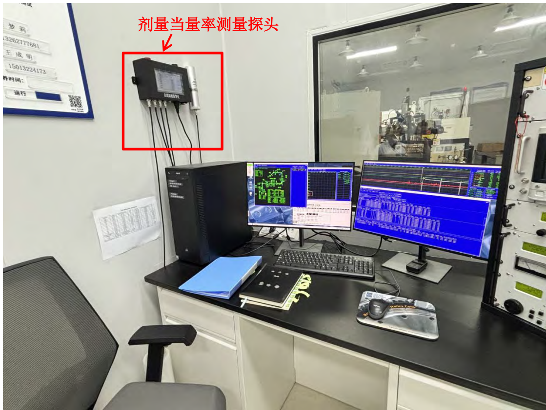
图 3-10 加速器质谱仪急停按钮现场安装位置
