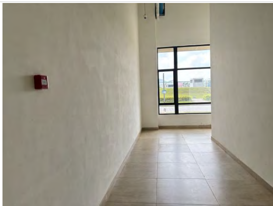
XCAMS 型加速器质谱仪北侧消防通道
