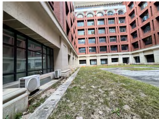
GeoScan200 型岩芯 CT 扫描仪南侧户外空地
