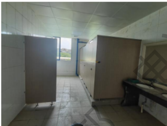
拟建位置西侧卫生间现状
