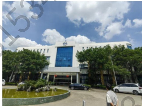
建设单位大楼现状
