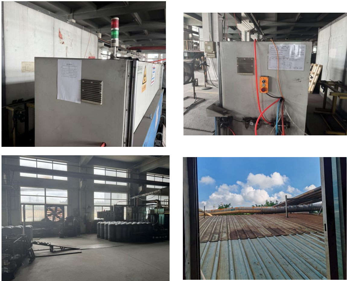
图 3-1 DU201 型 X 射线数字成像检测系统通风设施情况
