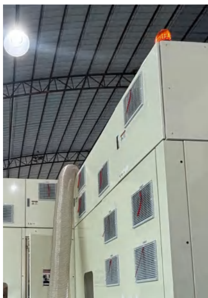
SPRK CP100 型在线 X 射线检测装置外部声音提醒装置
