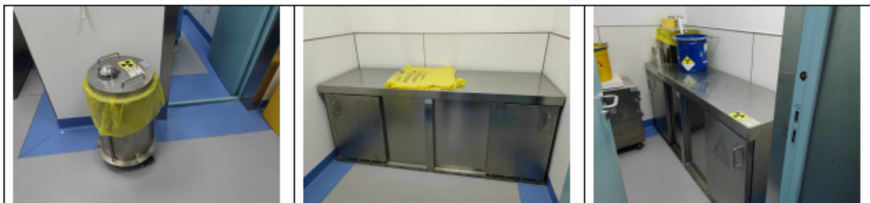
图 3-7 核素治疗场所的铅废物桶和铅废物箱实物图
