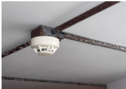
图3-14 1#加速器机房烟雾报警
