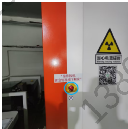
图 3-9 射线装置外部正面急停按钮（蓝圈为急停按钮）
