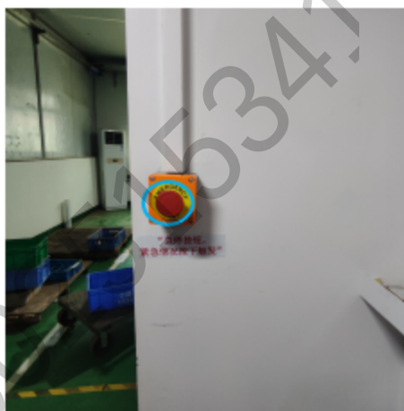
图 3-10 射线装置内部急停按钮（蓝圈为急停按钮）
