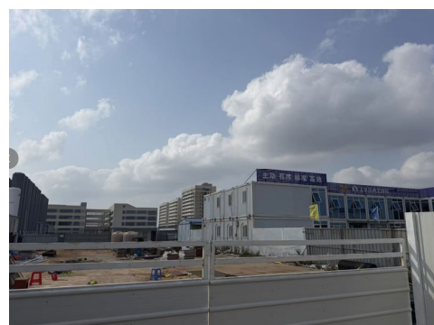
大毛牛二期建设用地和施工方项目部
