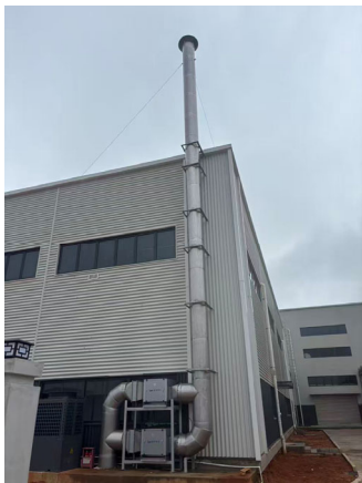
厂房内通风管道
