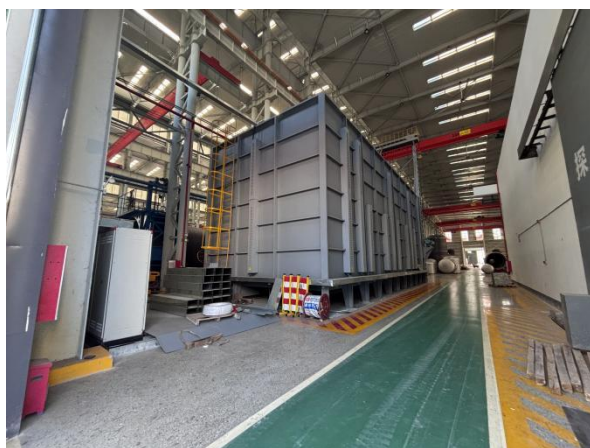
探伤室 2 南侧轻型设备组装车间通道
