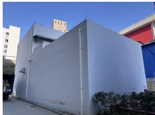
探伤室东侧设备房
