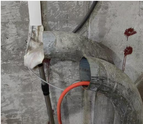
图 3-6 线缆穿墙辐射屏蔽补偿示意图
