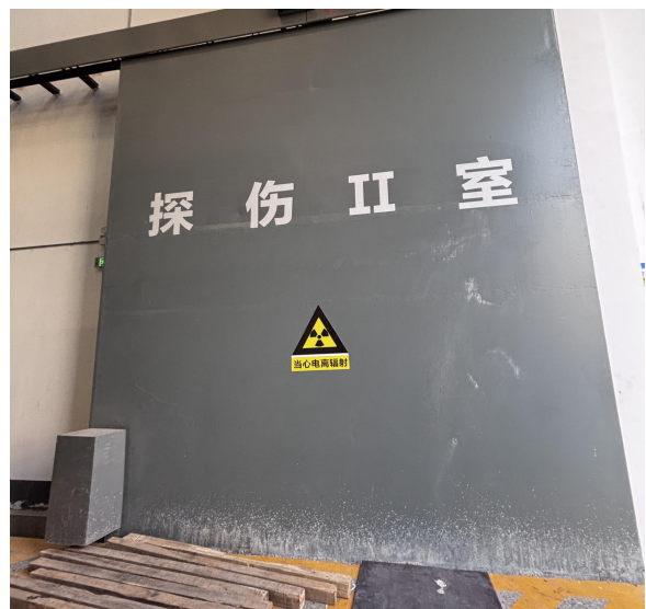
探伤室大防护门
