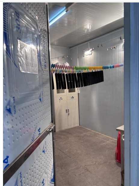
探伤室 1 北侧洗片室（晾片室）
