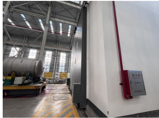
探伤室 1 西侧探伤工件进出通道
