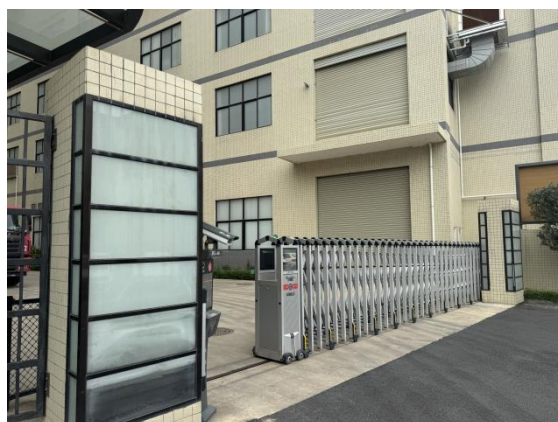
东南侧厂区门口
