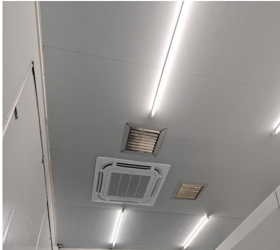
图 3-17 CT 测试房的通风装置
