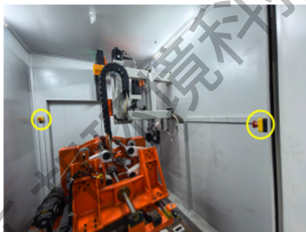
屏蔽铅房内的急停按钮实物图
