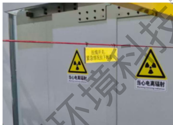
拉线开关标识及使用方法
