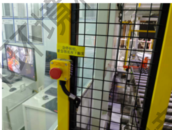
屏蔽铅房外的急停按钮实物图
