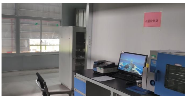
主机室西北侧备件室
