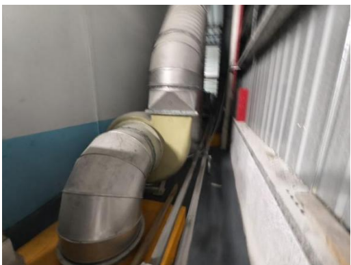
辐照室西南侧通道
