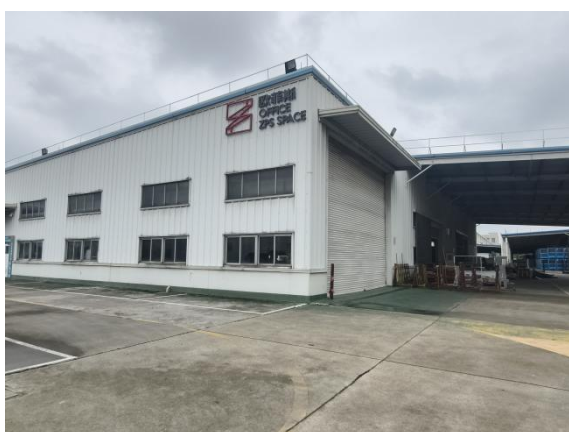
车间西南侧厂房
