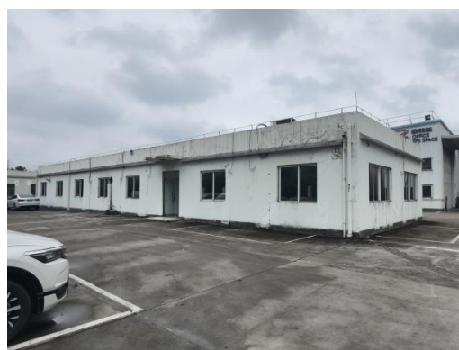
车间西南侧食堂
