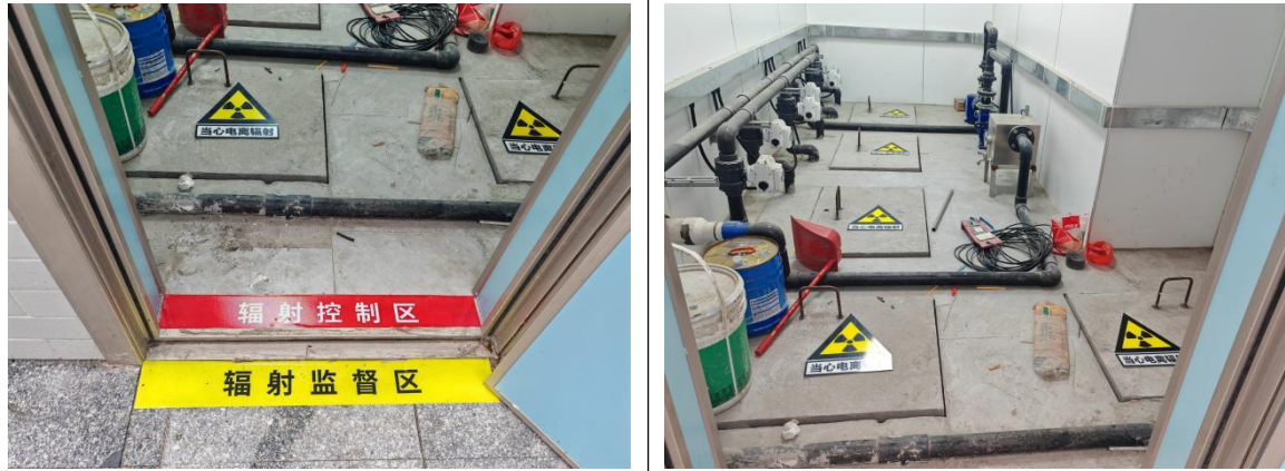
图 3-1 核医学科工作场所监督区控制区划分及现场图片
