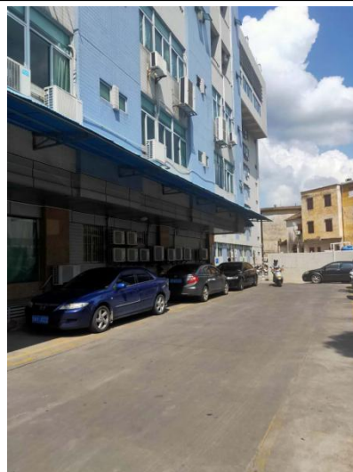
项目拟建场地四周（南侧）现状
