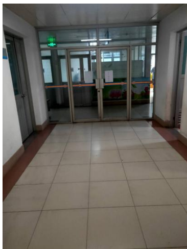
项目拟建场地四周（北侧）现状
